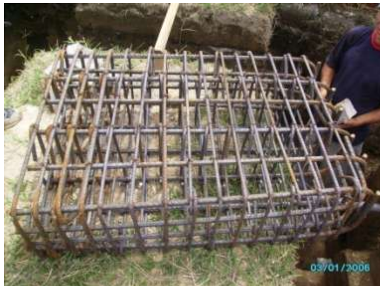
ARMADO DE CANASTILLAS ACERO DE REFUERZO
