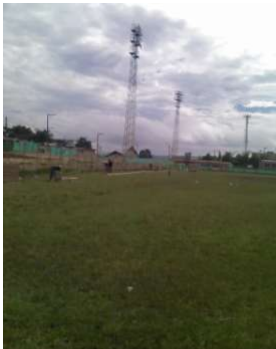
LOCALIZACION Y REPLANTEO
