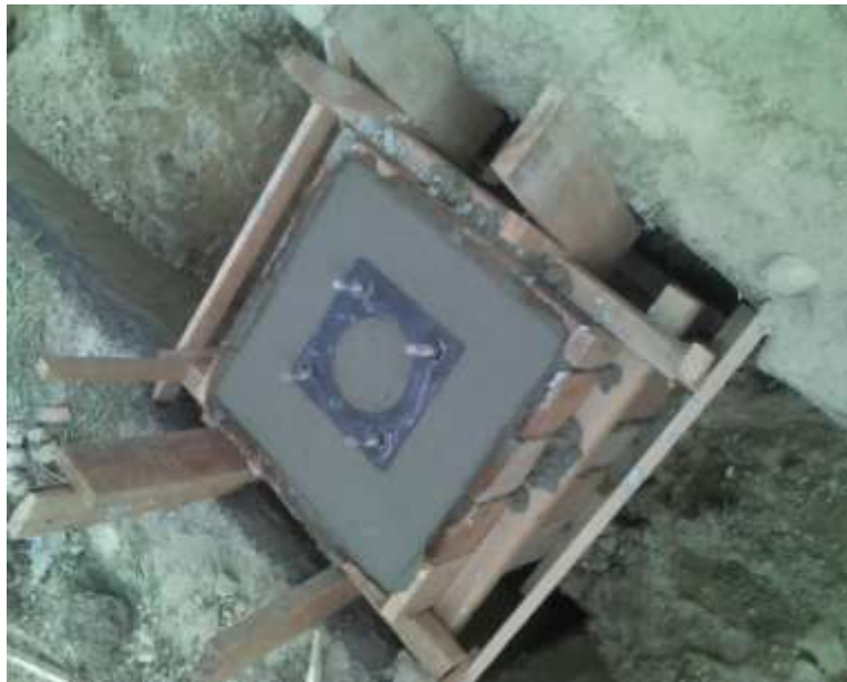
INSTALACION DE PLATINAS GUIA DE ANCLAJES
