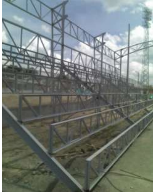
MONTAJE CERCHAS GRADERIAS
