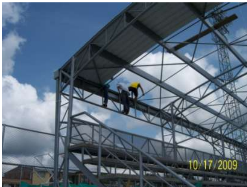
INSTALACION DE CUBIERTA
