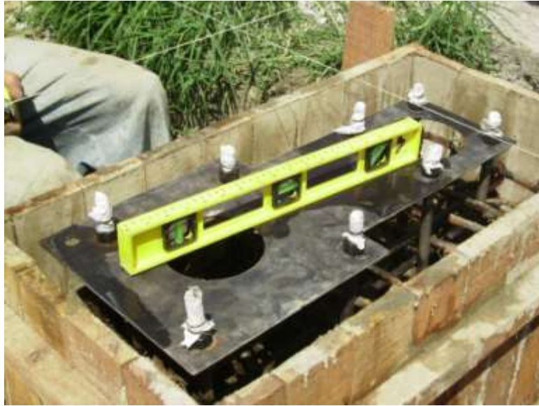
NIVELACION DE PLATINAS GUIA DE ANCLAJES
