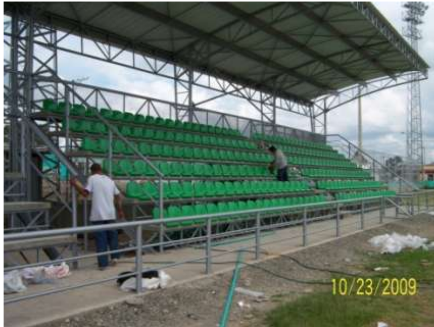
INSTALACION DE SILLETERIA
