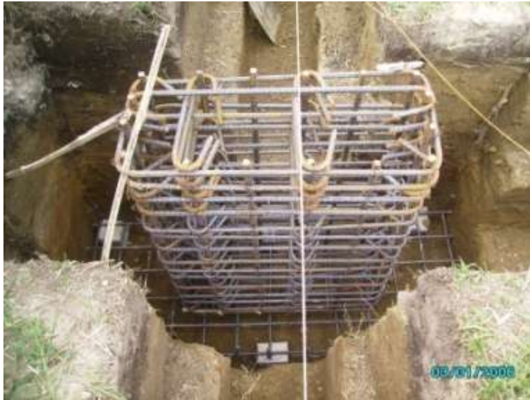
ARMADO DE CANASTILLAS ACERO DE REFUERZO
