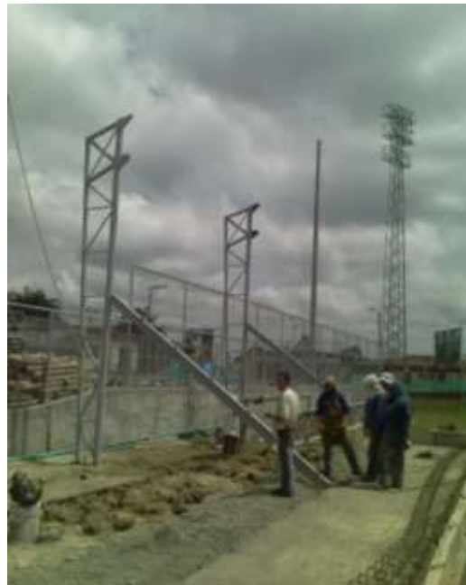
INICIO MONTAJE ESTRUCTURA METALICA
