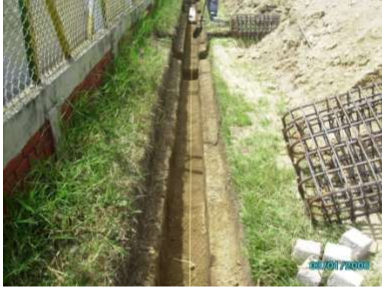
EXCAVACIONES ZAPATAS, VIGAS Y COLUMNAS
