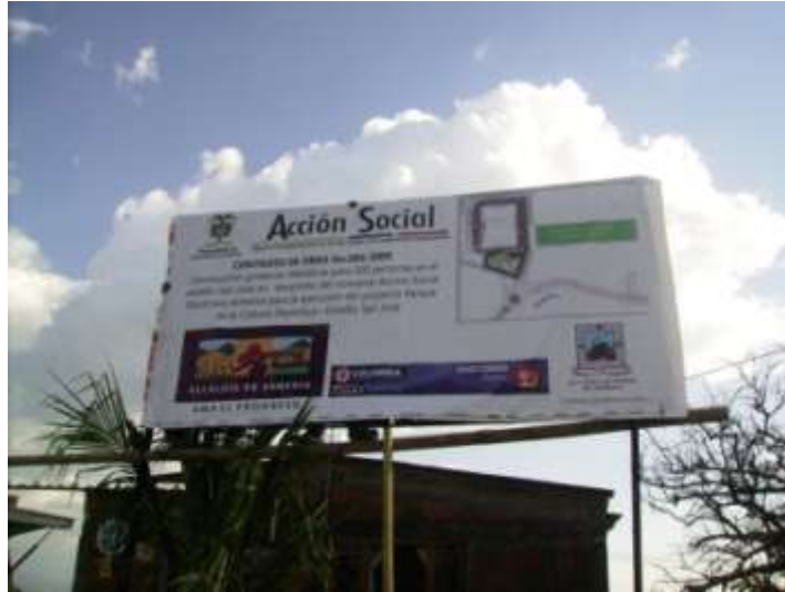
INSTALACION DE VALLA EN OBRA
