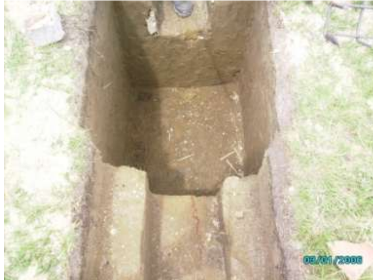
EXCAVACIONES ZAPATAS, VIGAS Y COLUMNAS
