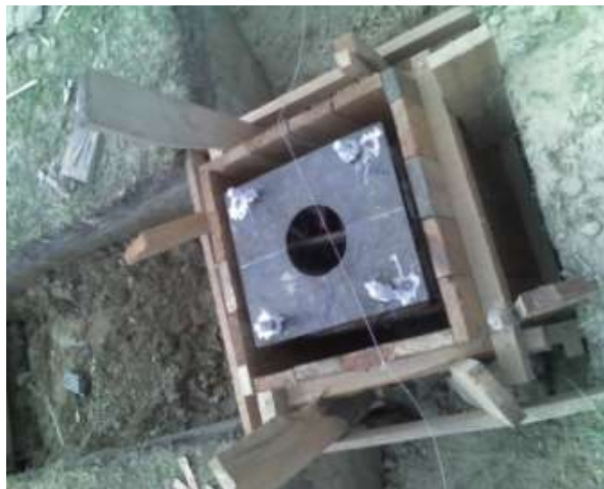
INSTALACION DE PLATINAS GUIA DE ANCLAJES
